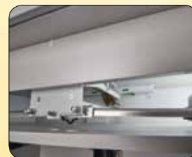
Двери со специальной блокировочной системой, удерживающей их открытыми в любом положении и обеспечивающей автоматическое закрытие в случае пожара
