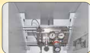
Удобные инсталляционные направляющие для установки газораспределительной фурнитуры*
